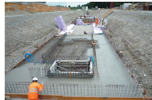
Tiefbauarbeiten bei der neuen JVA Solothurn.
