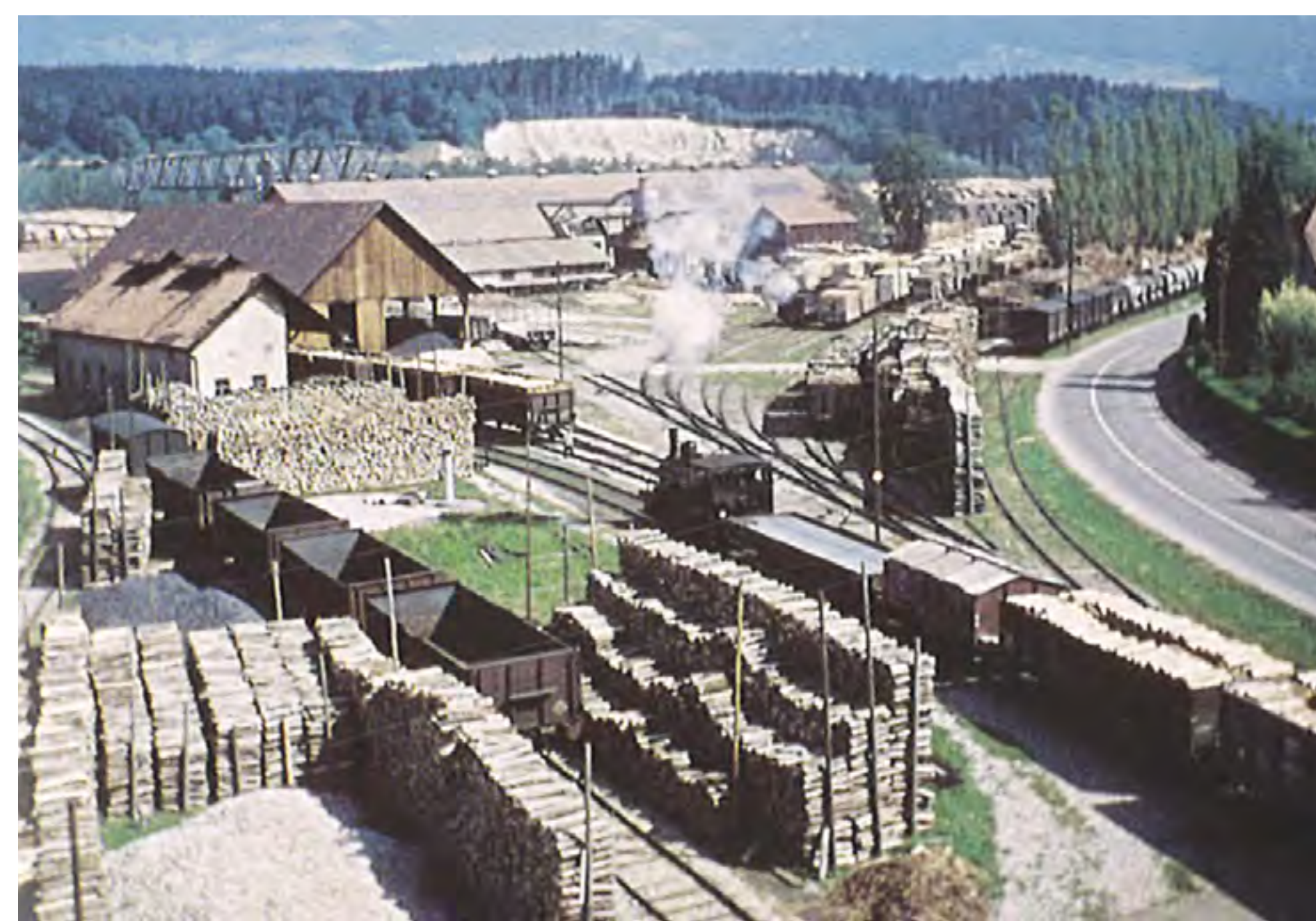
Cellulose Attisholz mit einem Schienennetz von über 15 km Länge
