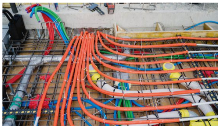
Die Leitungen sind im Beton selbst verlegt. MATTHIAS KÄSER
