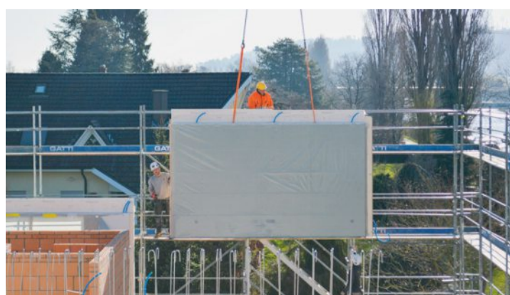
Die Holzwände tragen die Betondecke. YANN STAFFELBACH
